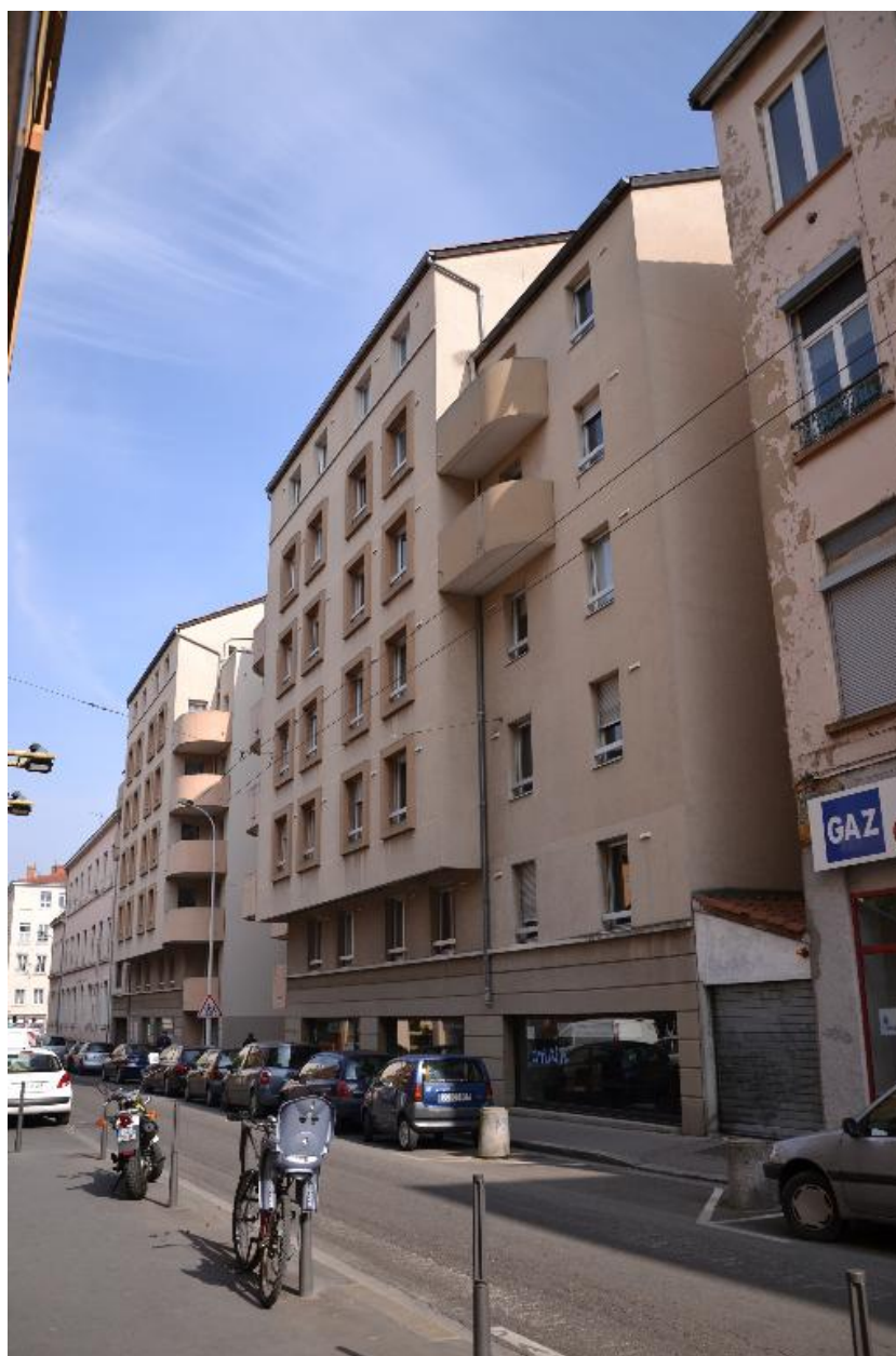
Vue d'ensemble façade ouest
