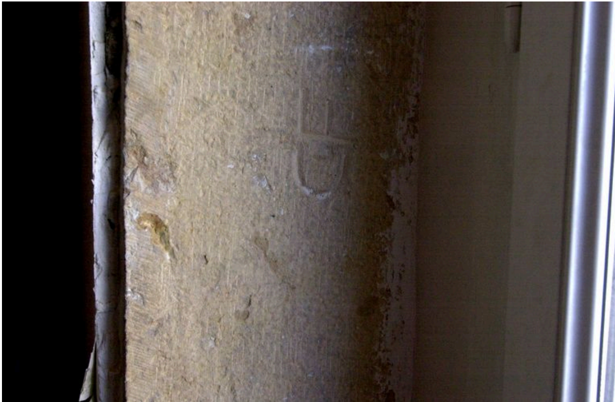
Marques de tâcheron CF sur un encadrement de fenêtre
