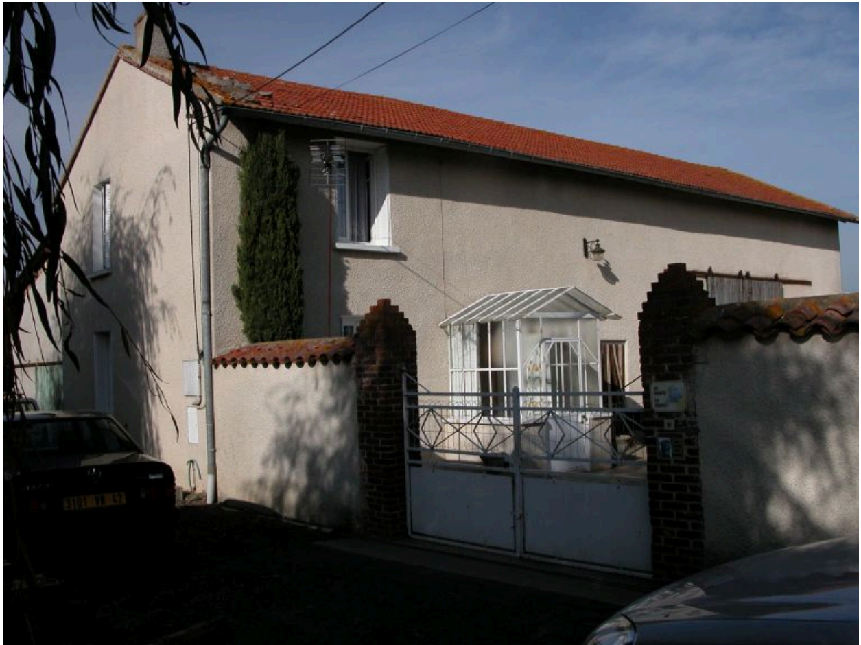
Vue générale du logis depuis le chemin.
