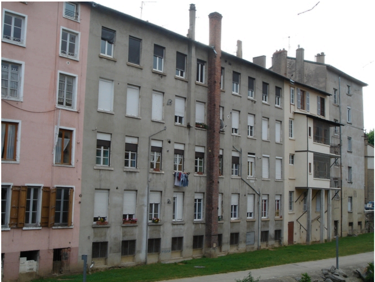
Façade sur Gère
