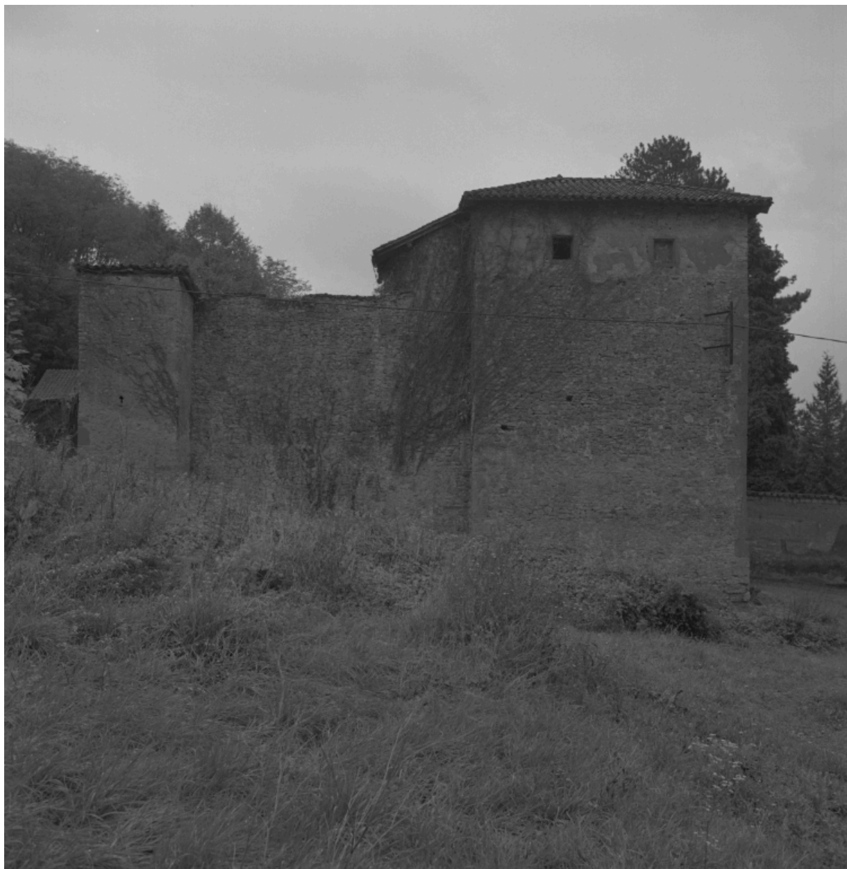
Elévation latérale nord-est sur le chemin .
