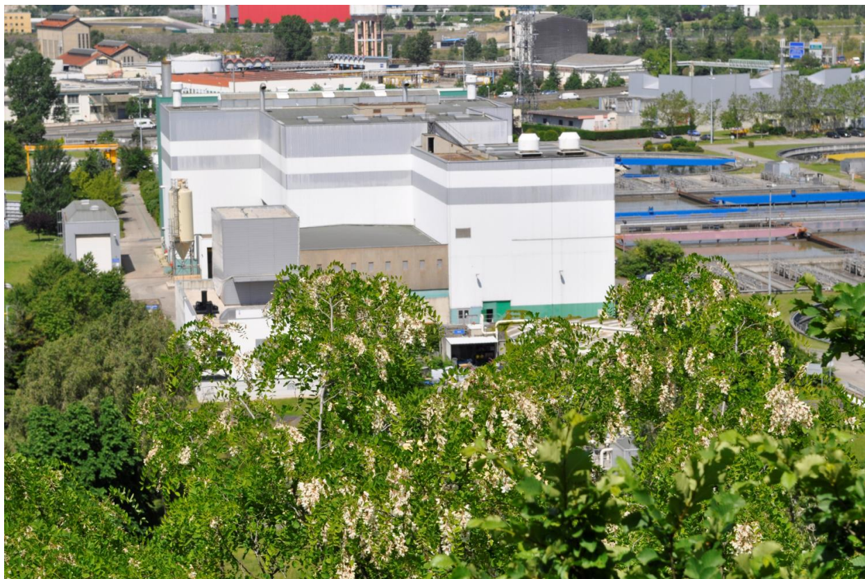
Détail bâtiment de production
