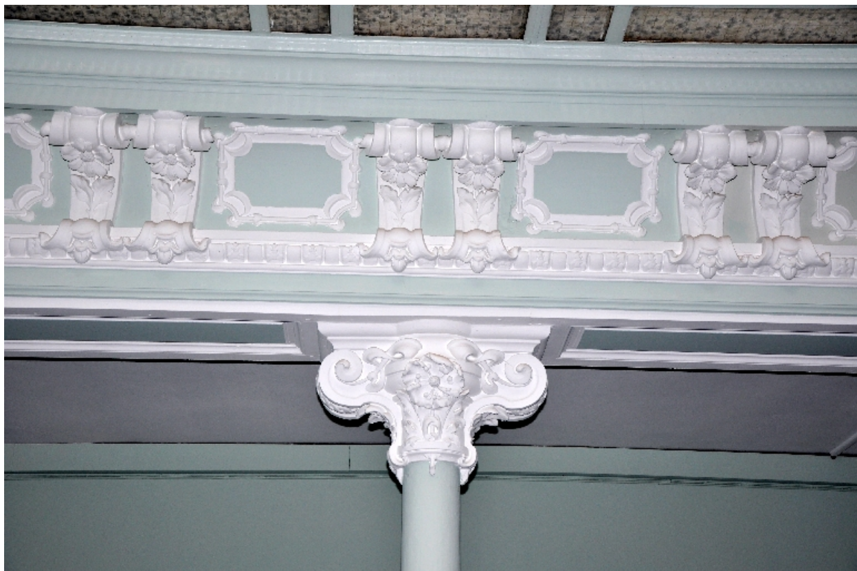
Corps principal, atrium : chapiteau et frise
