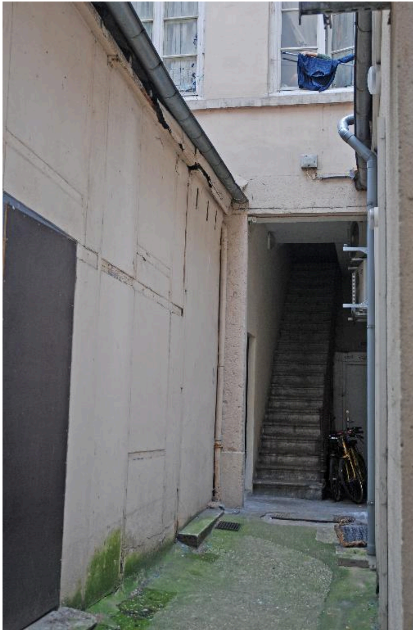
Vue partielle de la cour et départ de l'escalier de l'immeuble sur cour
