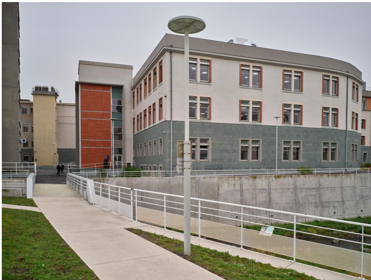
Le bâtiment T2 depuis le nord (état 2022).
