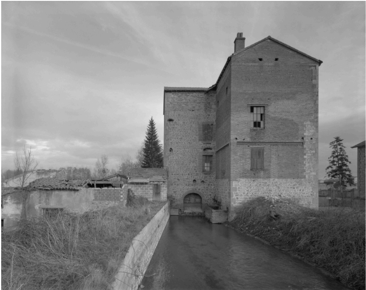
Vue d'ensemble de l'élévation ouest du moulin, avec l'arrivée du bief.
