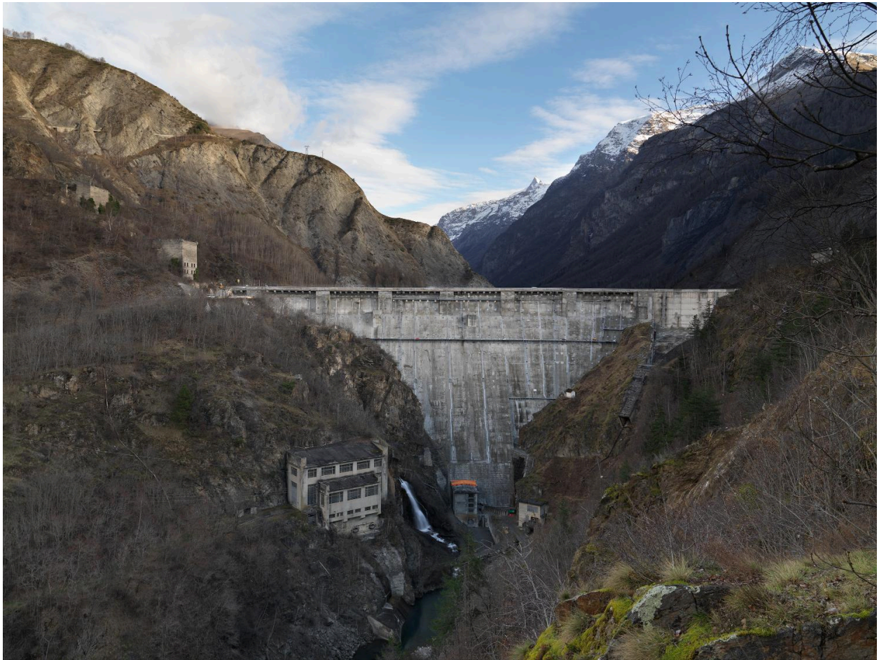
Vue d'ensemble du barrage du Chambon.
