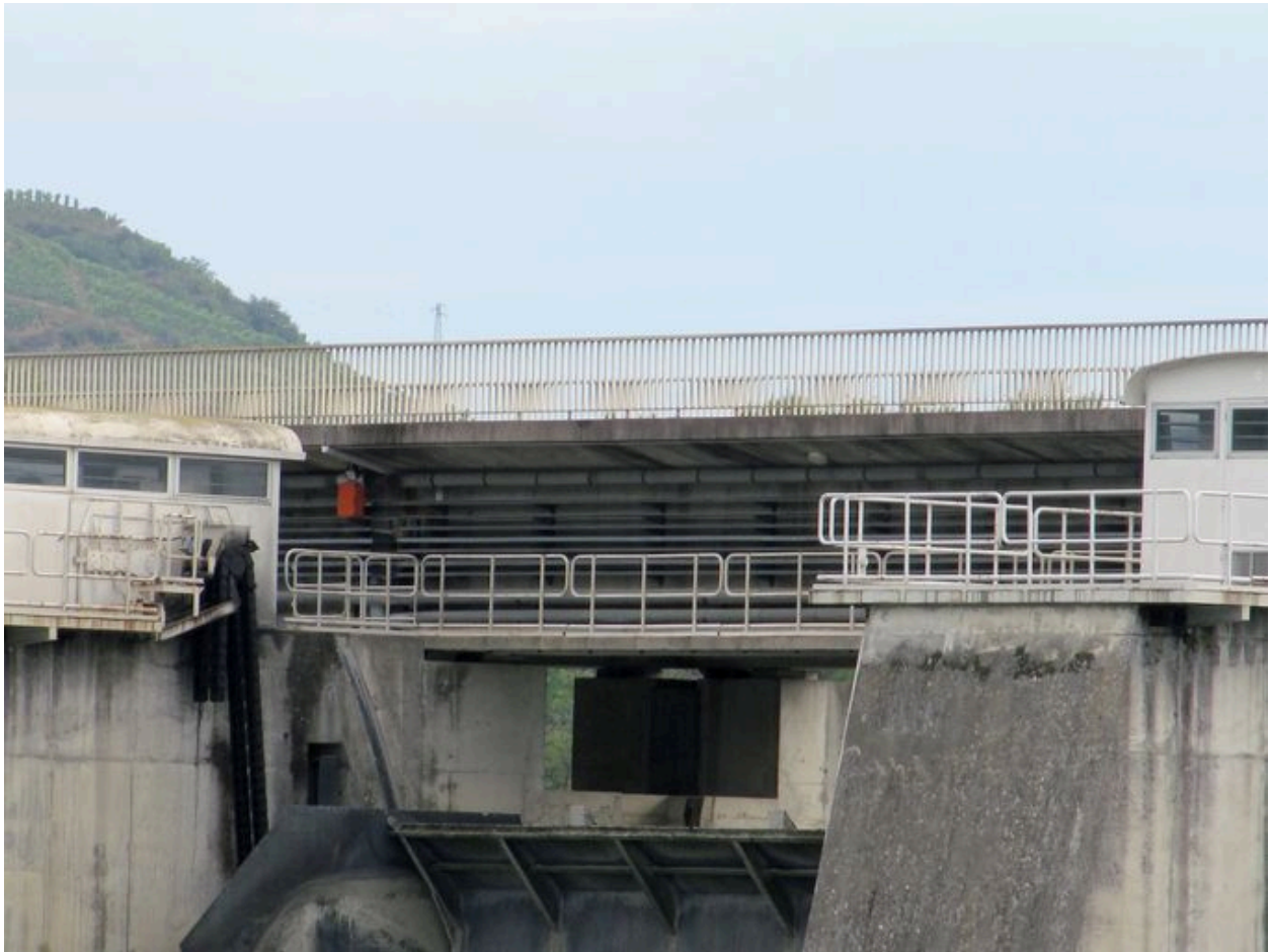
Pont routier et passerelle, vue partielle face aval (depuis la rive gauche)
