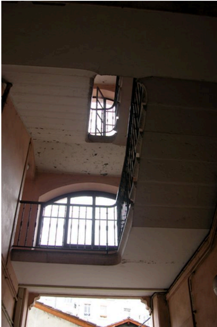
Vue de la cage d'escalier et du passage de l'escalier au-dessus du passage couvert
