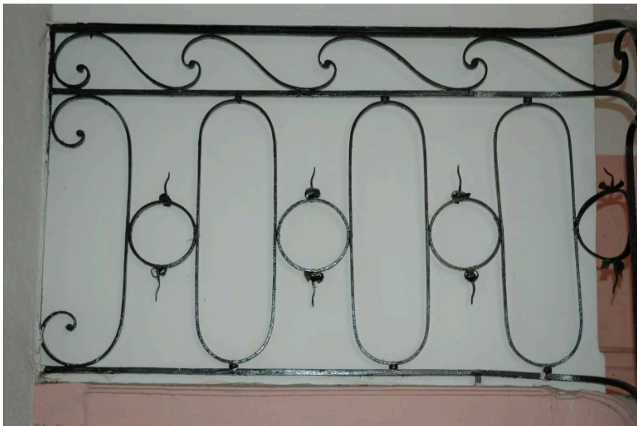
Rampe du palier.
