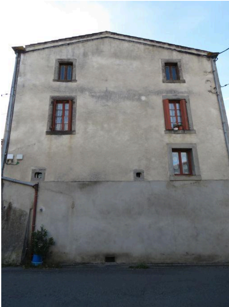
Vue générale : élévation latérale
