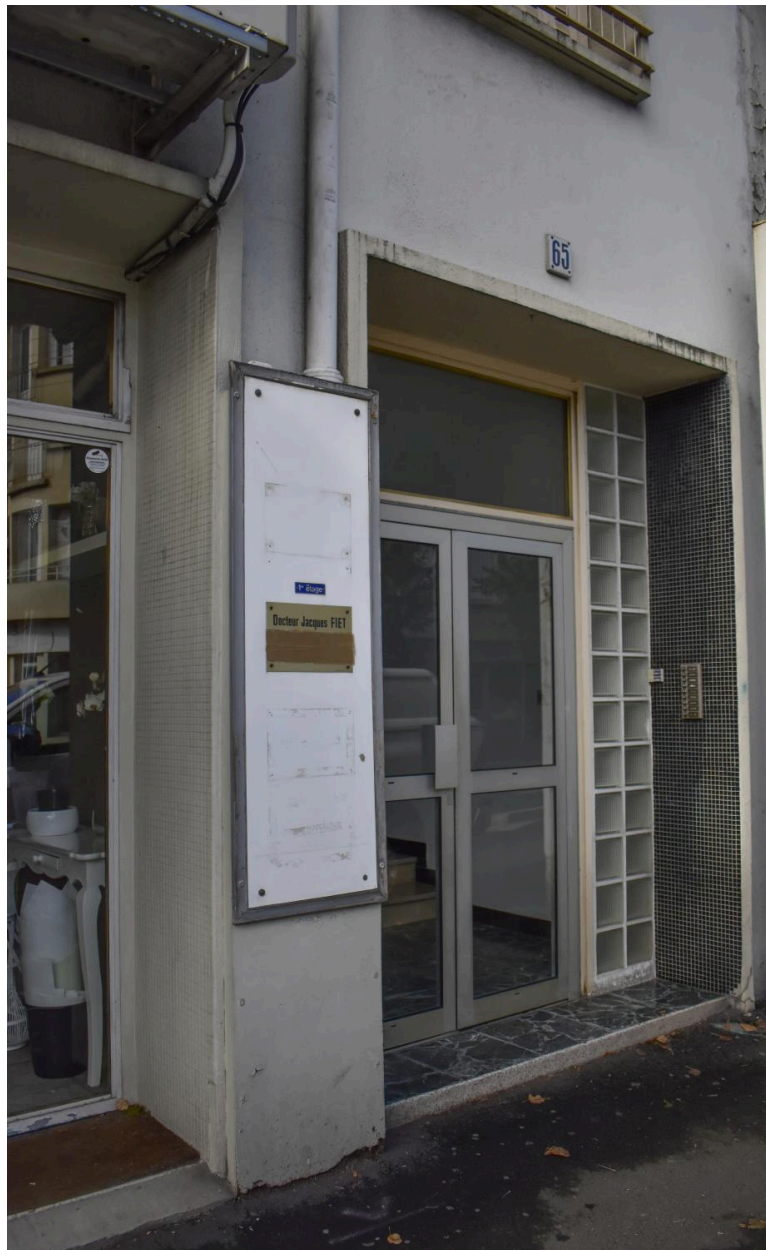
Porte sur le boulevard Jean-Jaurès
