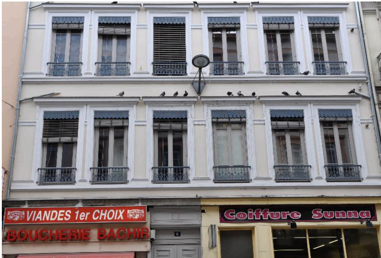
Vue rapprochée de l'élévation sur rue : décor des premier et deuxième étages carrés
