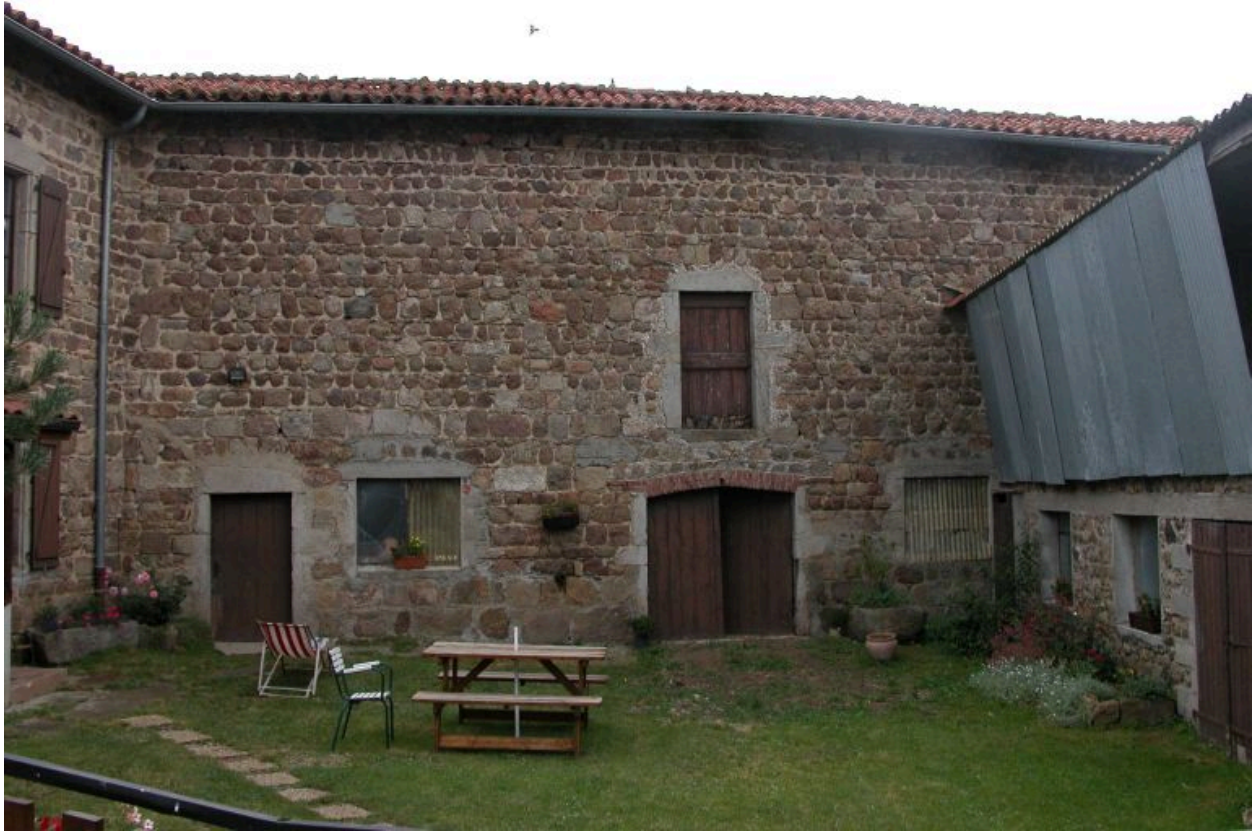
Vue d'ensemble de la façade sur cour de la grange-étable.
