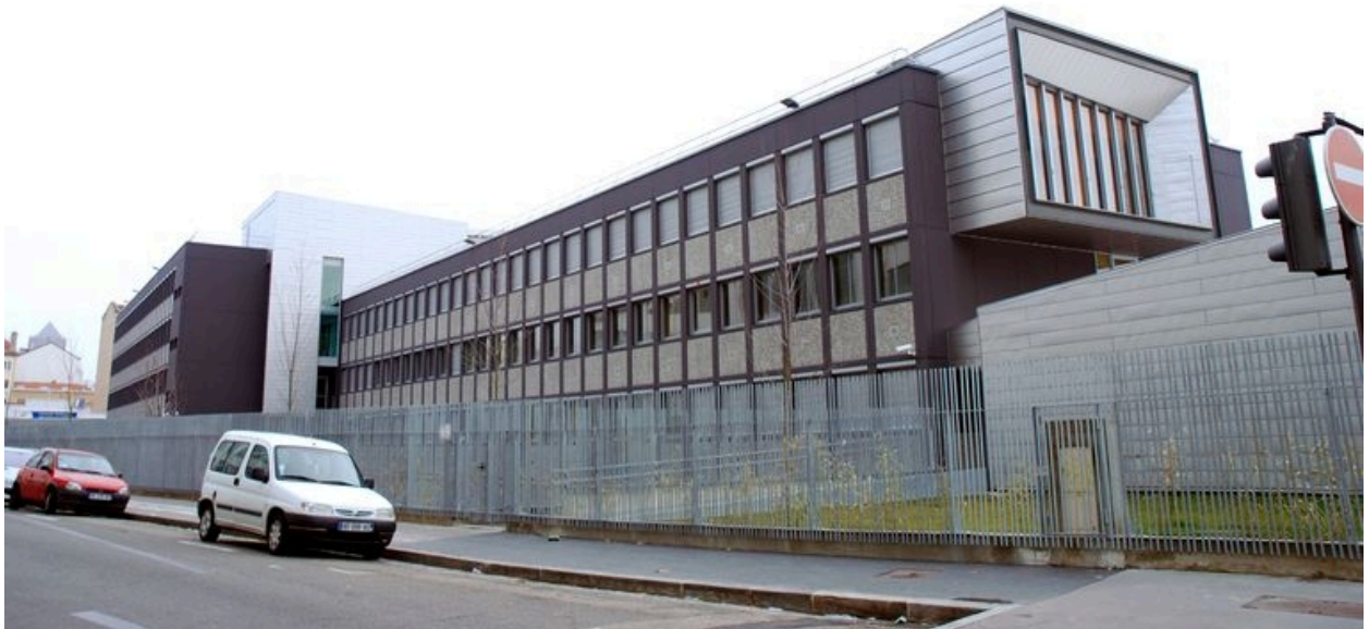
Vue des élévations ouest, depuis la rue Béchevelin.
