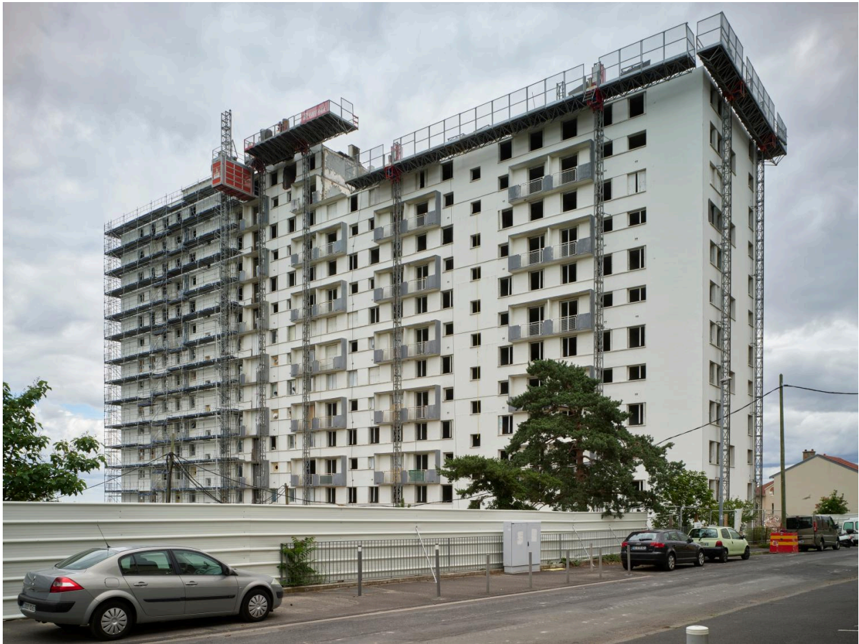
Immeuble de l'allée des Dômes, en cours de déconstruction, au 30 juin 2021.
