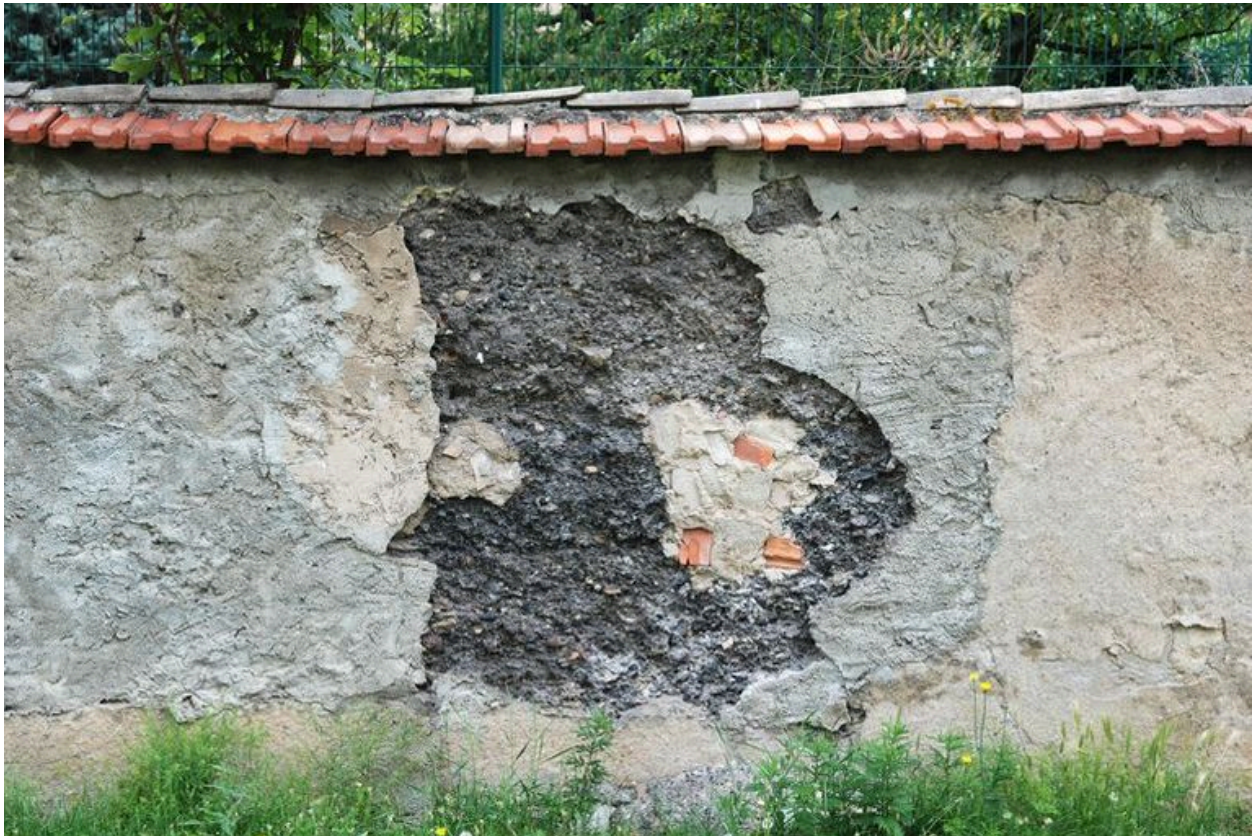
Détail du mur de clôture d'origine en mâchefer et pisé
