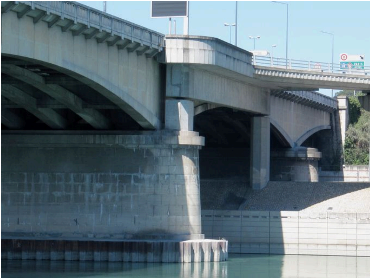
Vue partielle, accès routier et travée de rive droite, face amont (depuis la rive gauche)
