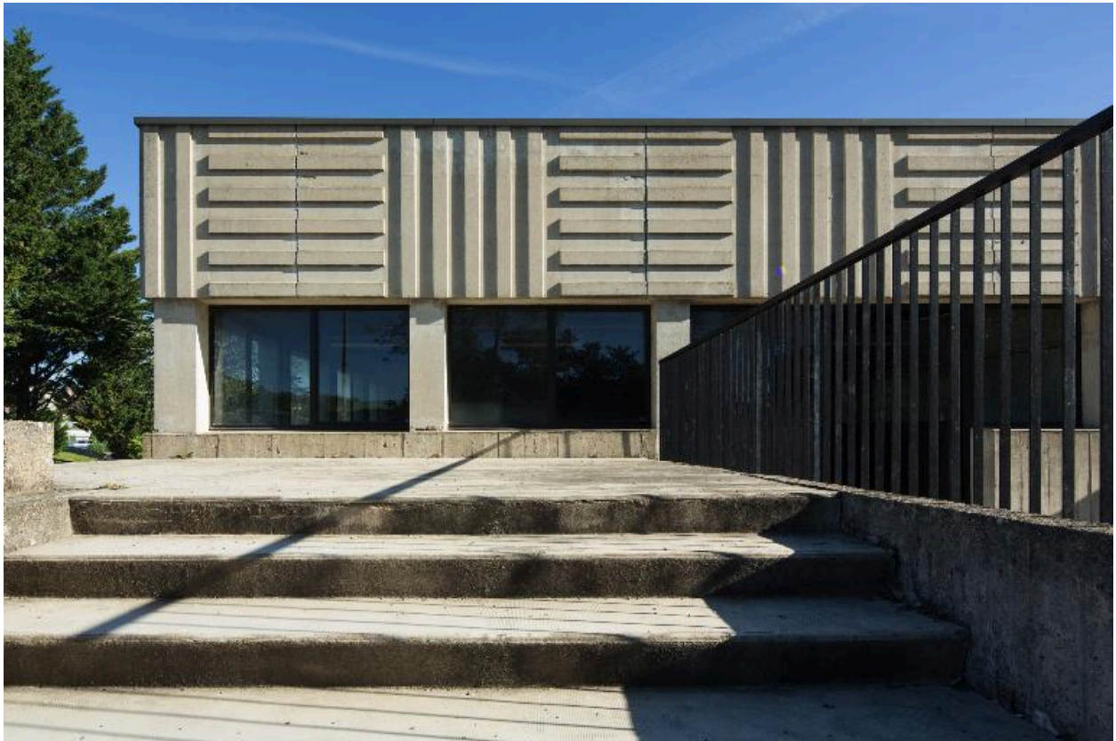
Ateliers : façade sud, détail
