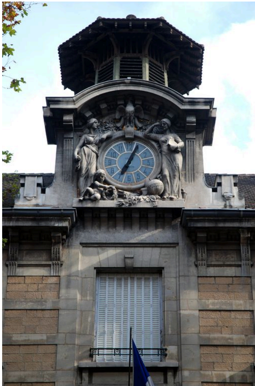
Elévation principale, détail de la baie centrale du 2e étage, horloge et campanile
