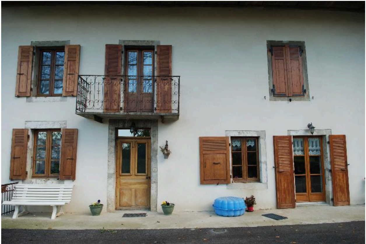
Vue partielle de la façade avant de la ferme.
