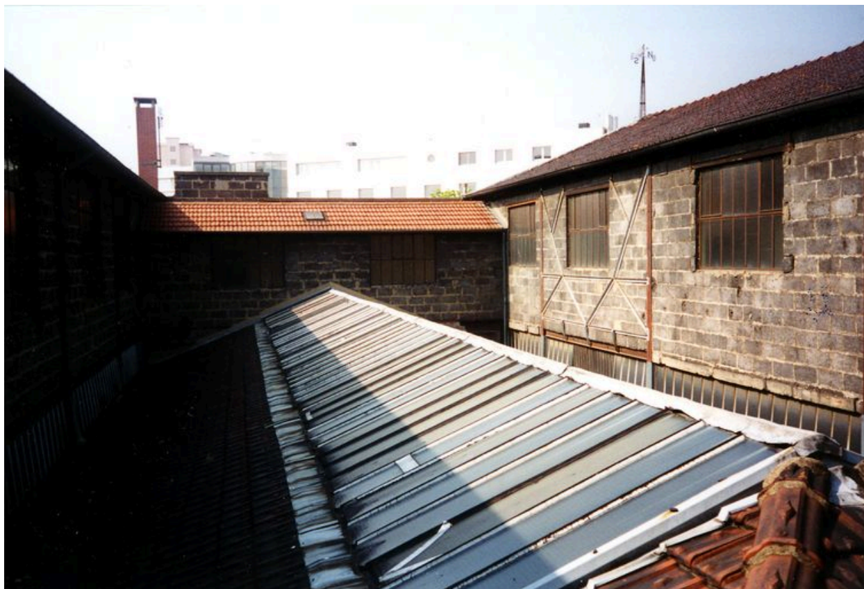
Vue d'anciennes toitures prise depuis la passerelle métallique, 1995
