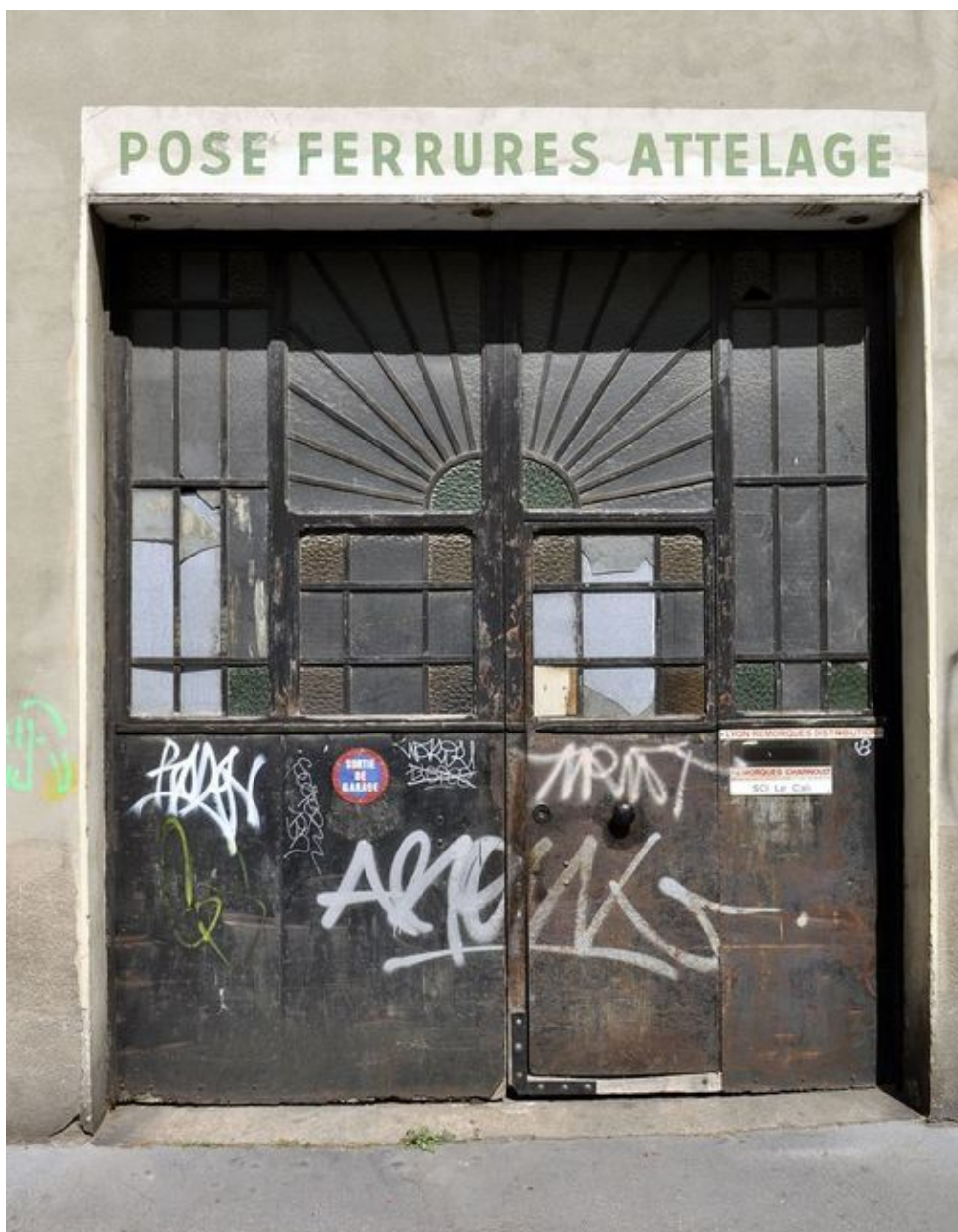
Façade principale : portail
