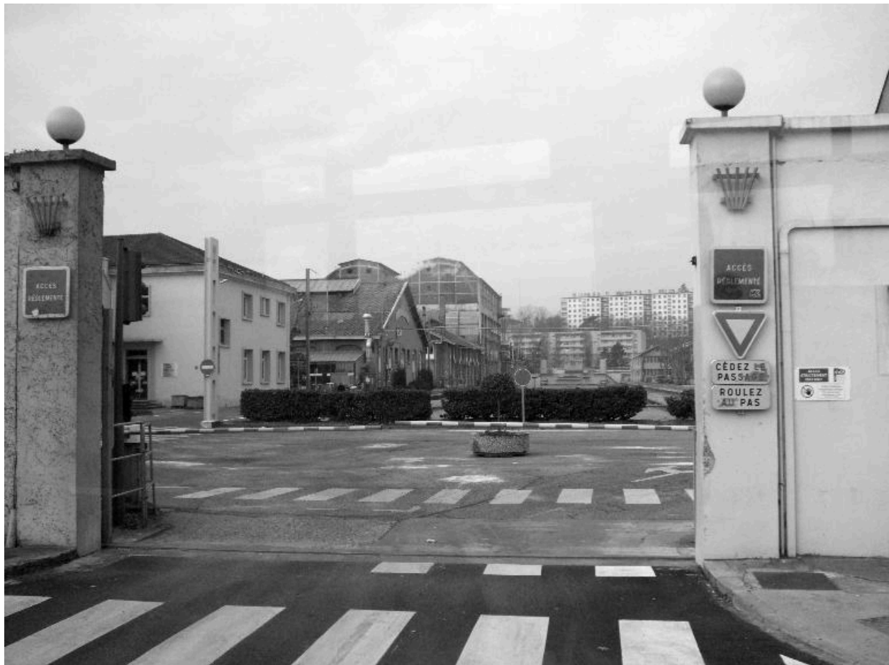
Entrée poste Rhône, entrée du site
