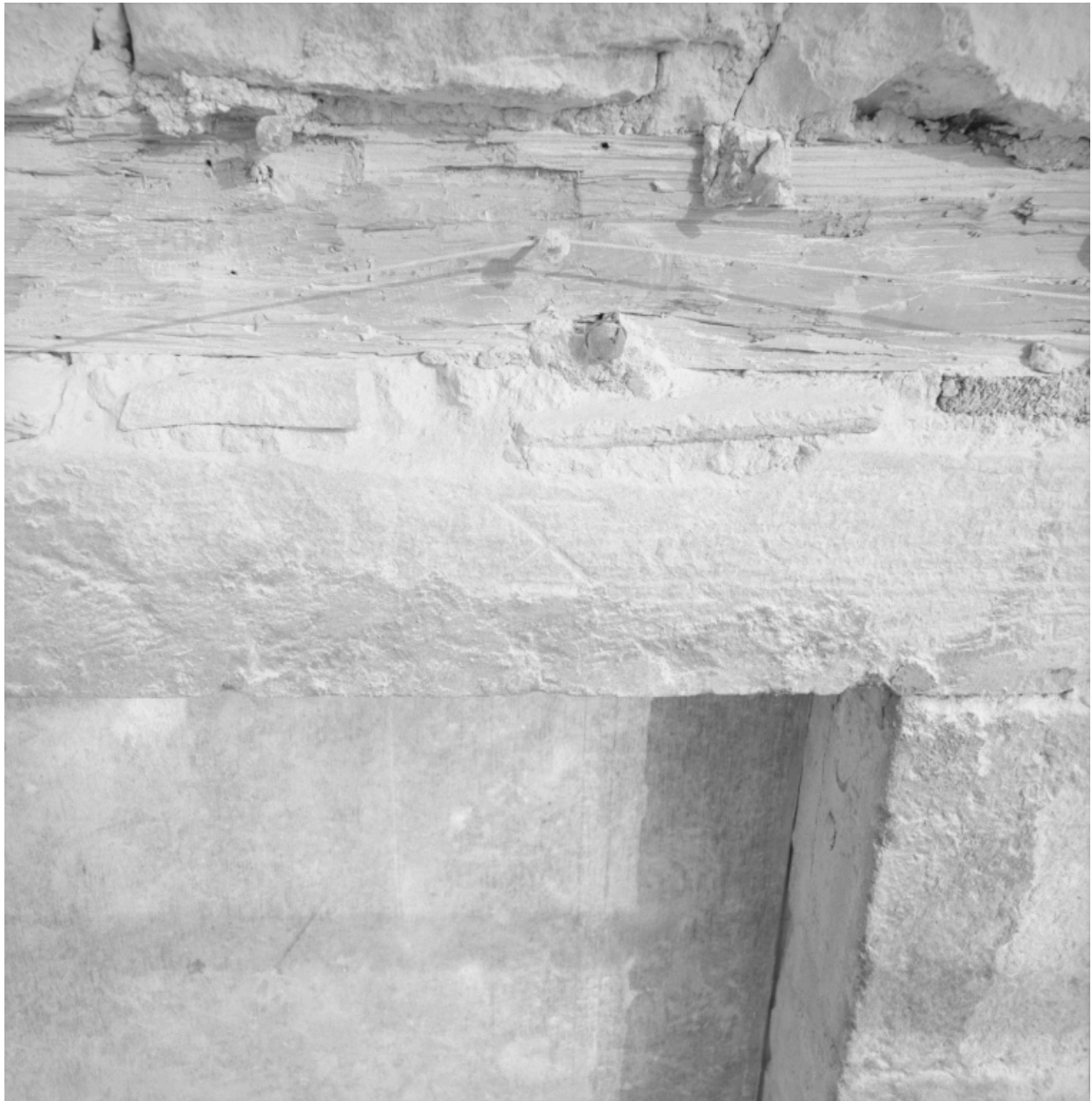
Etude archéologique de la façade principale : niveau 1. Remploi de linteau avec marques lapidaires (b).
