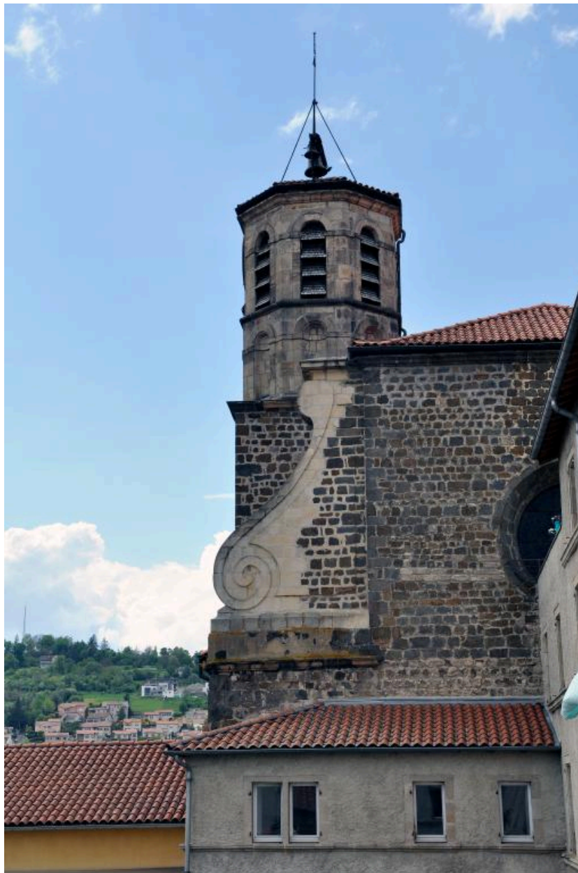
Vue du chevet et du clocher depuis l'est, depuis la 2e cour du collège
