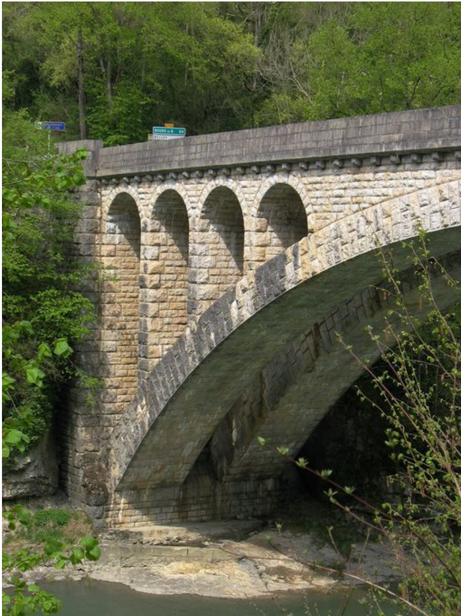
Vue partielle du pont, rive droite, face aval
