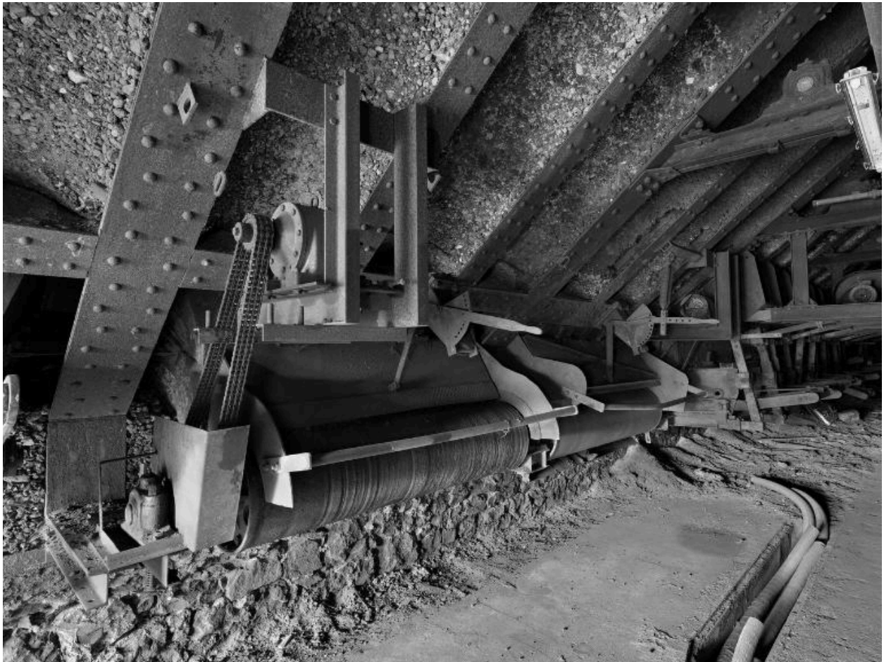
Vue intérieur du lavoir bâtiment-machine
