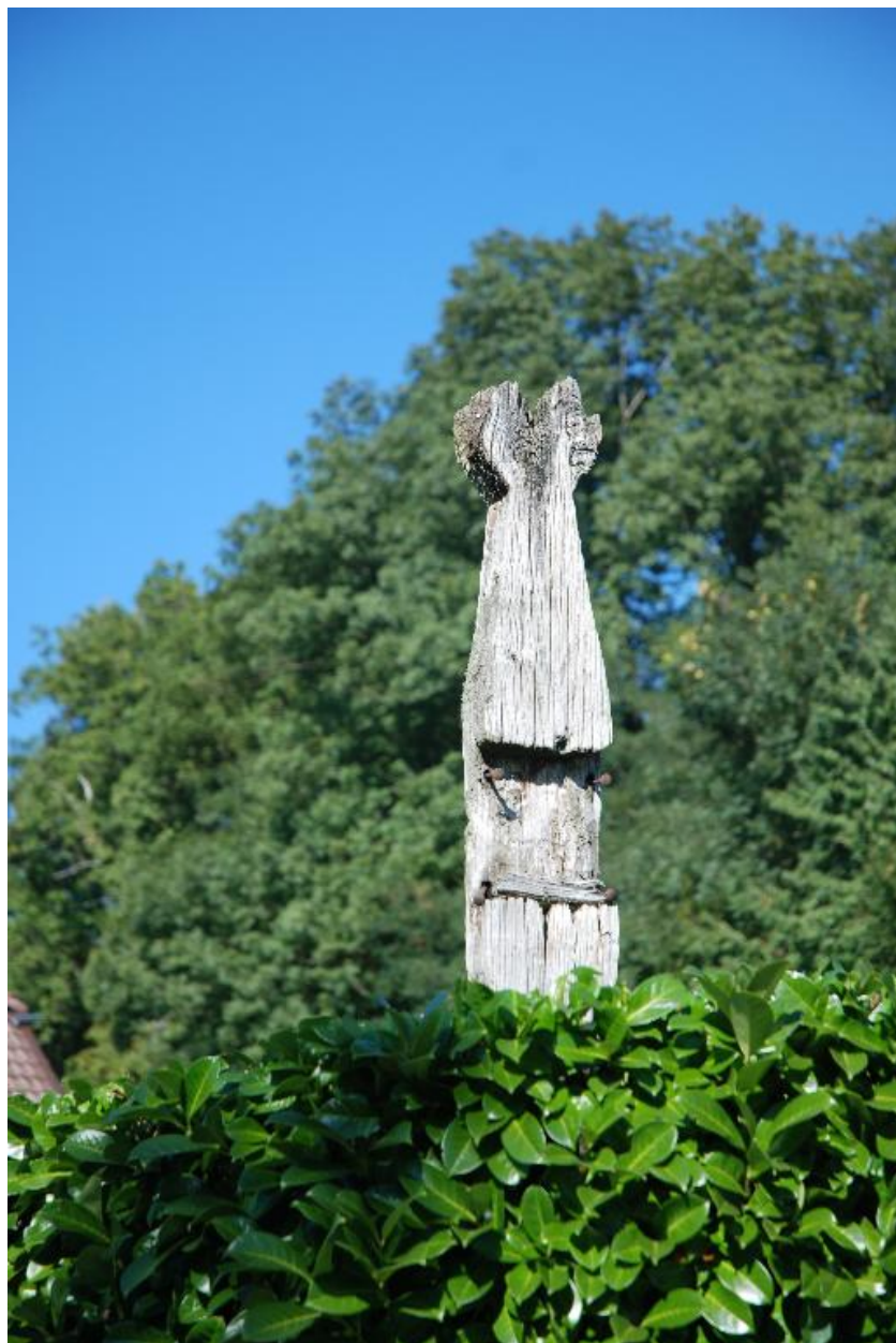
Vue du croisillon (état en septembre 2015).
