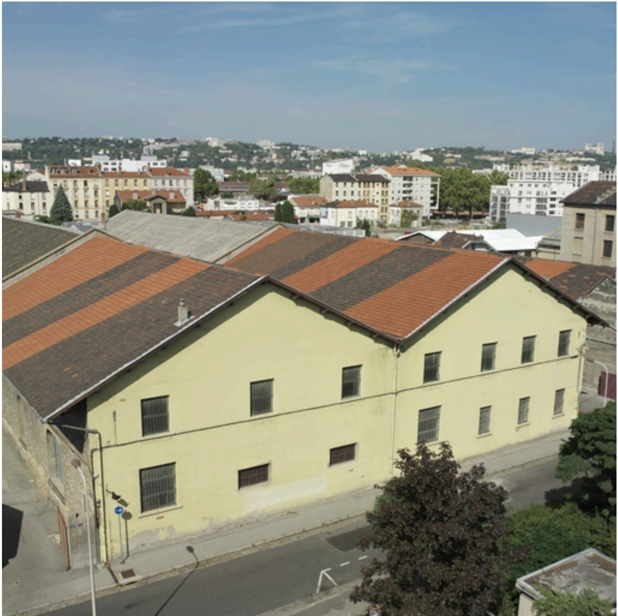
Vue d'ensemble de la double halle rue Massimi (sud-est)
