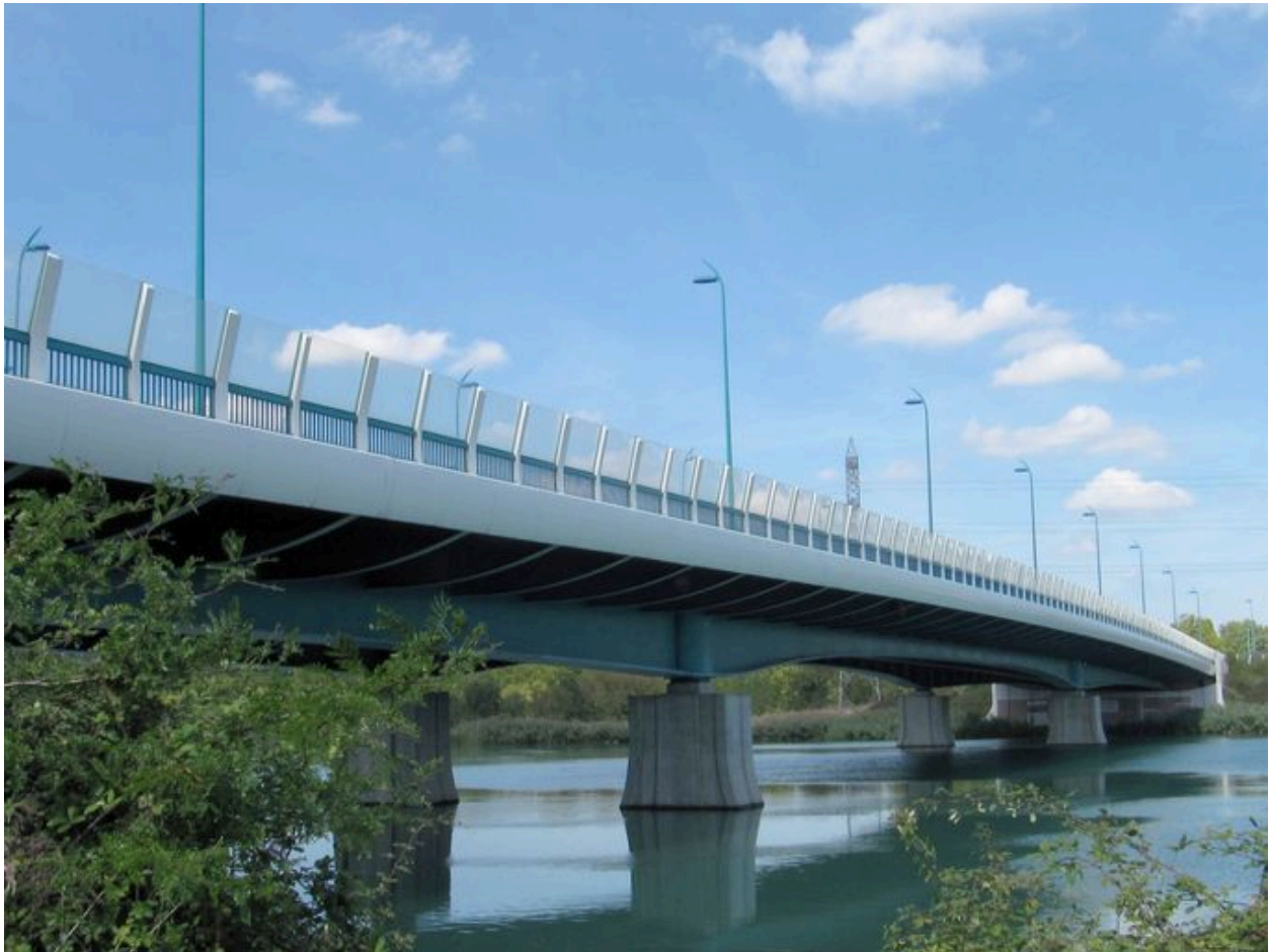
Vue générale, de côté, face amont (depuis la rive gauche)
