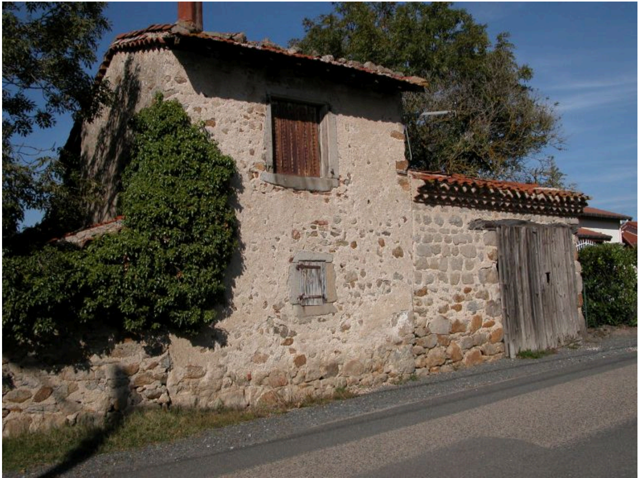
Vue générale depuis le sud.
