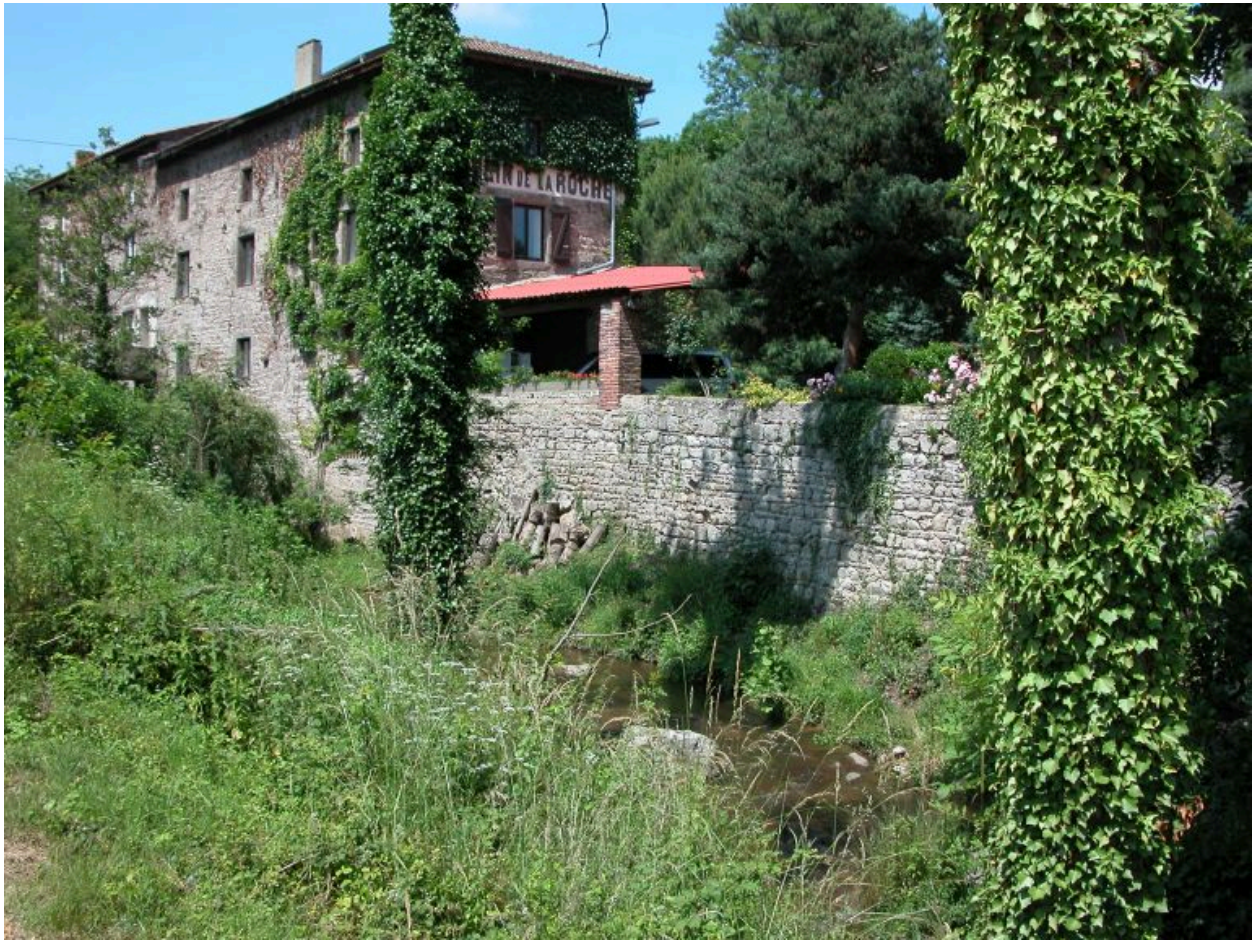
Vue partielle de la façade sud-est du moulin
