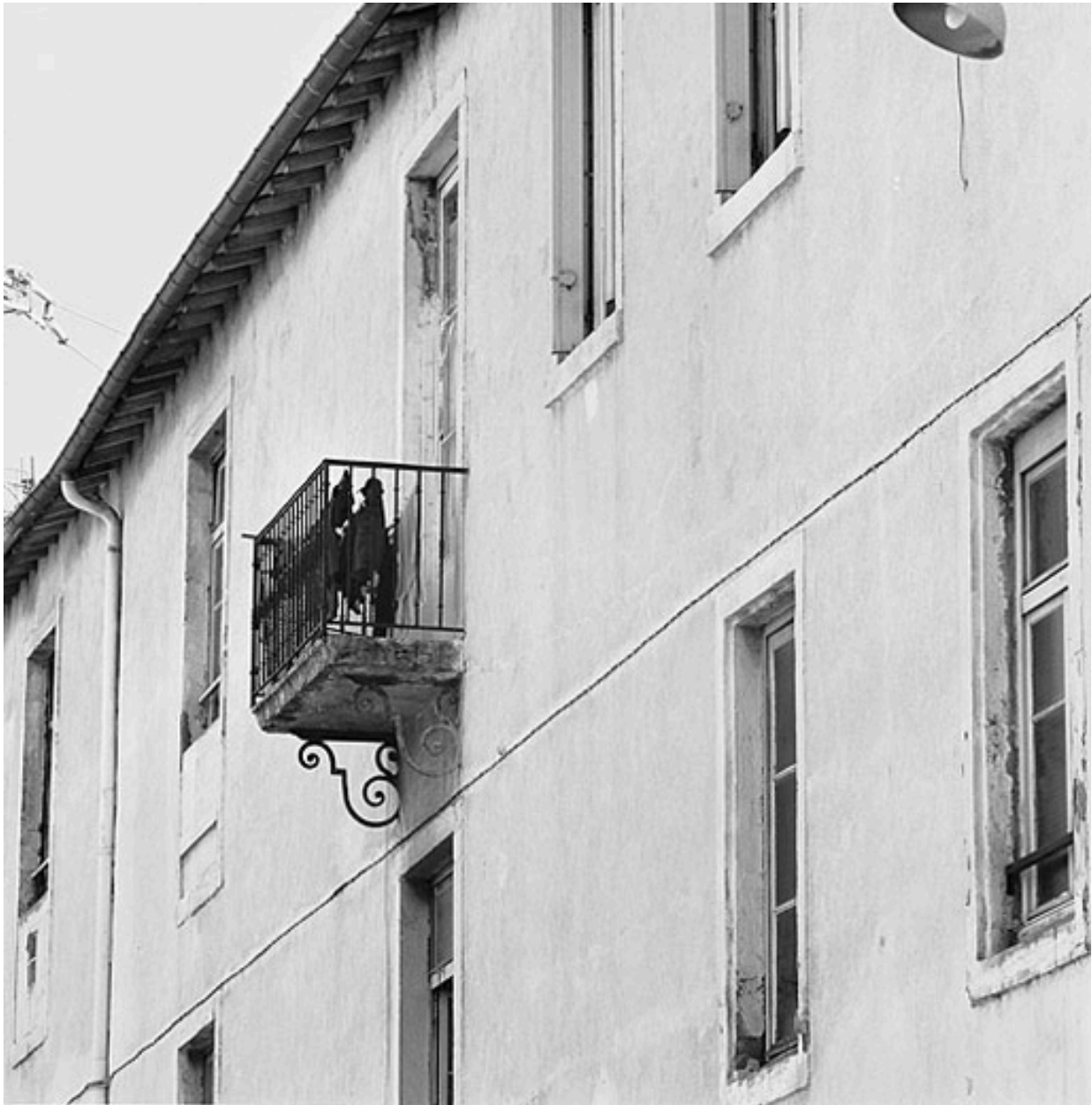
Balcon façade ouest
