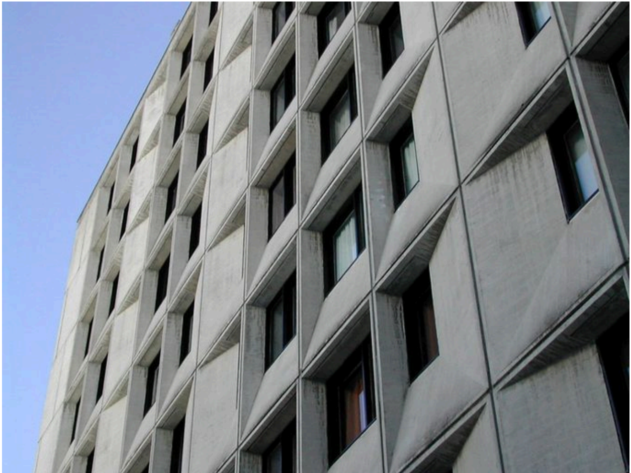
Détail des baies de la façade postérieure
