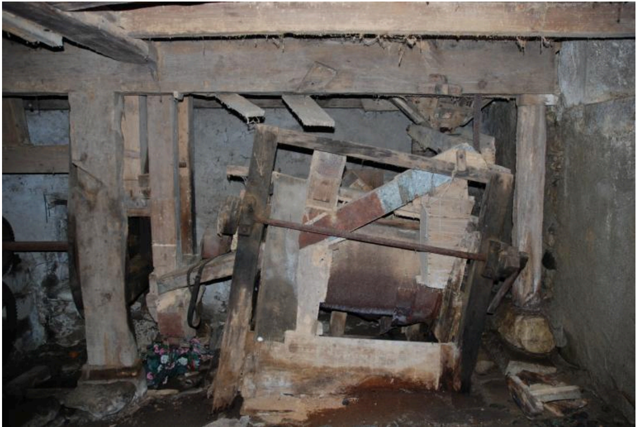
Vue intérieure de l'étage de soubassement, angle sud-est : cylindre.
