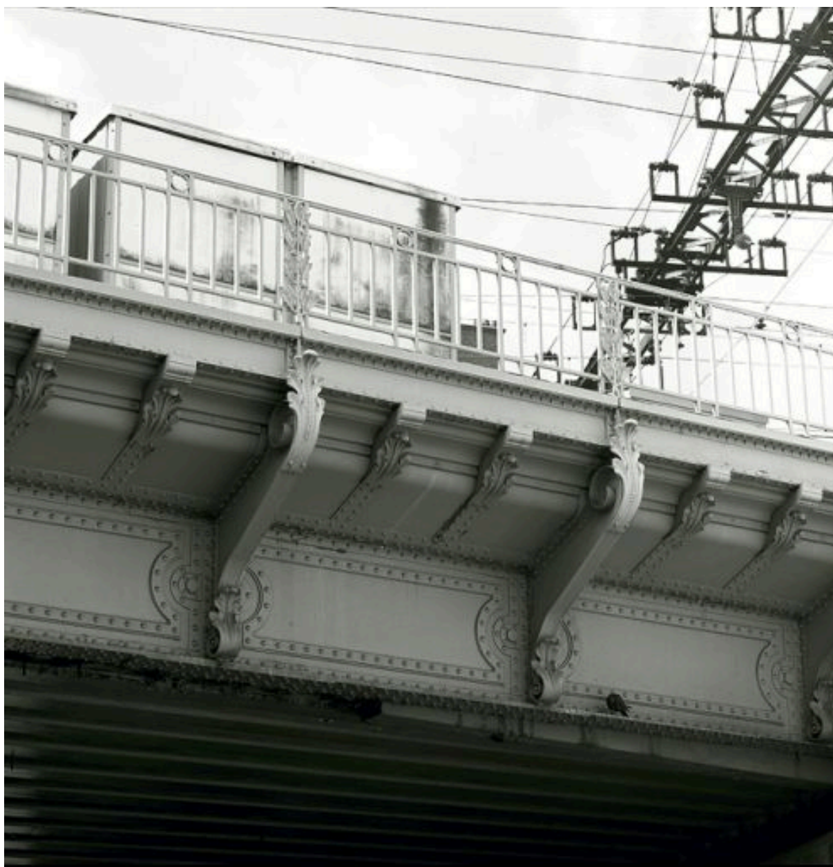
Travée de rive, quai Rambaud : détail des consoles métalliques du tablier
