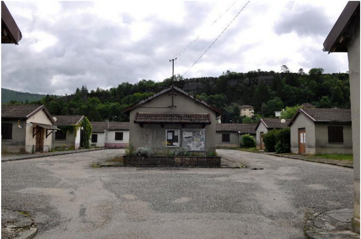
Vue frontale Ouest de la parcelle 201
