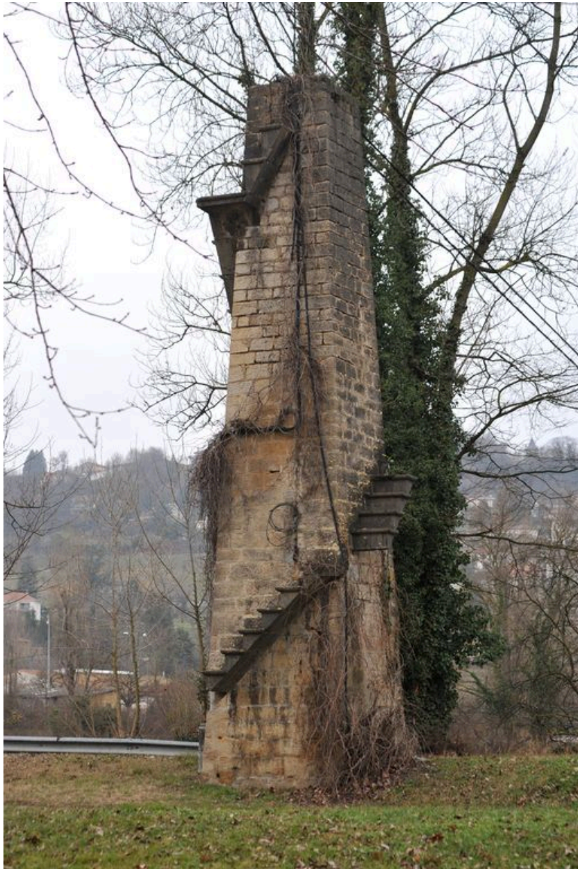
Pile gauche, angle est, vue générale (depuis la rive gauche)
