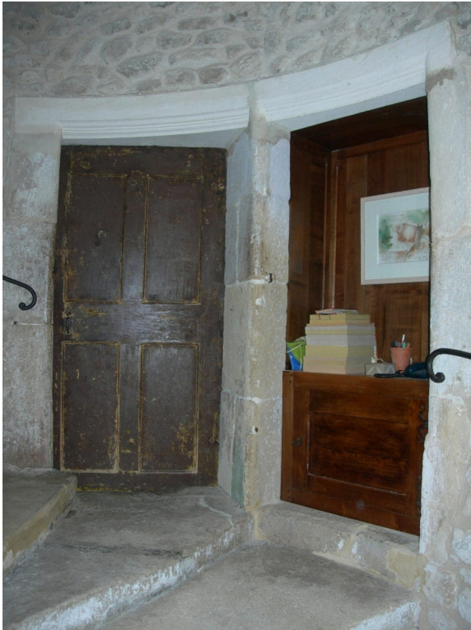
Escalier en vis, portes palières jumelées du premier étage.
