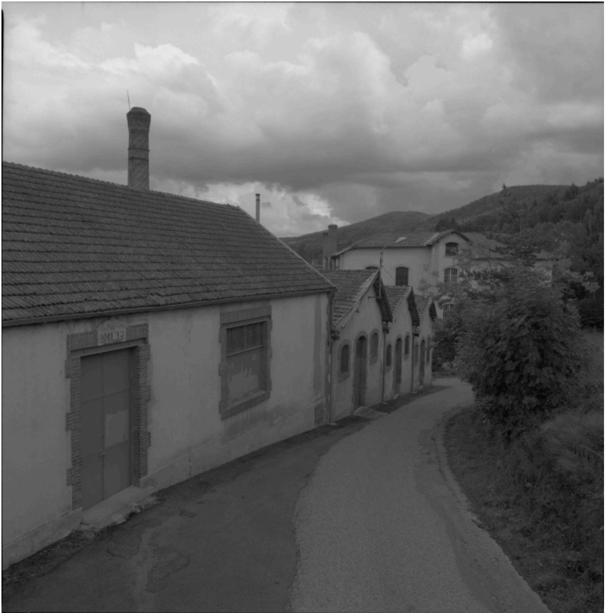
Détail des sheds des ateliers construits en 1901.
