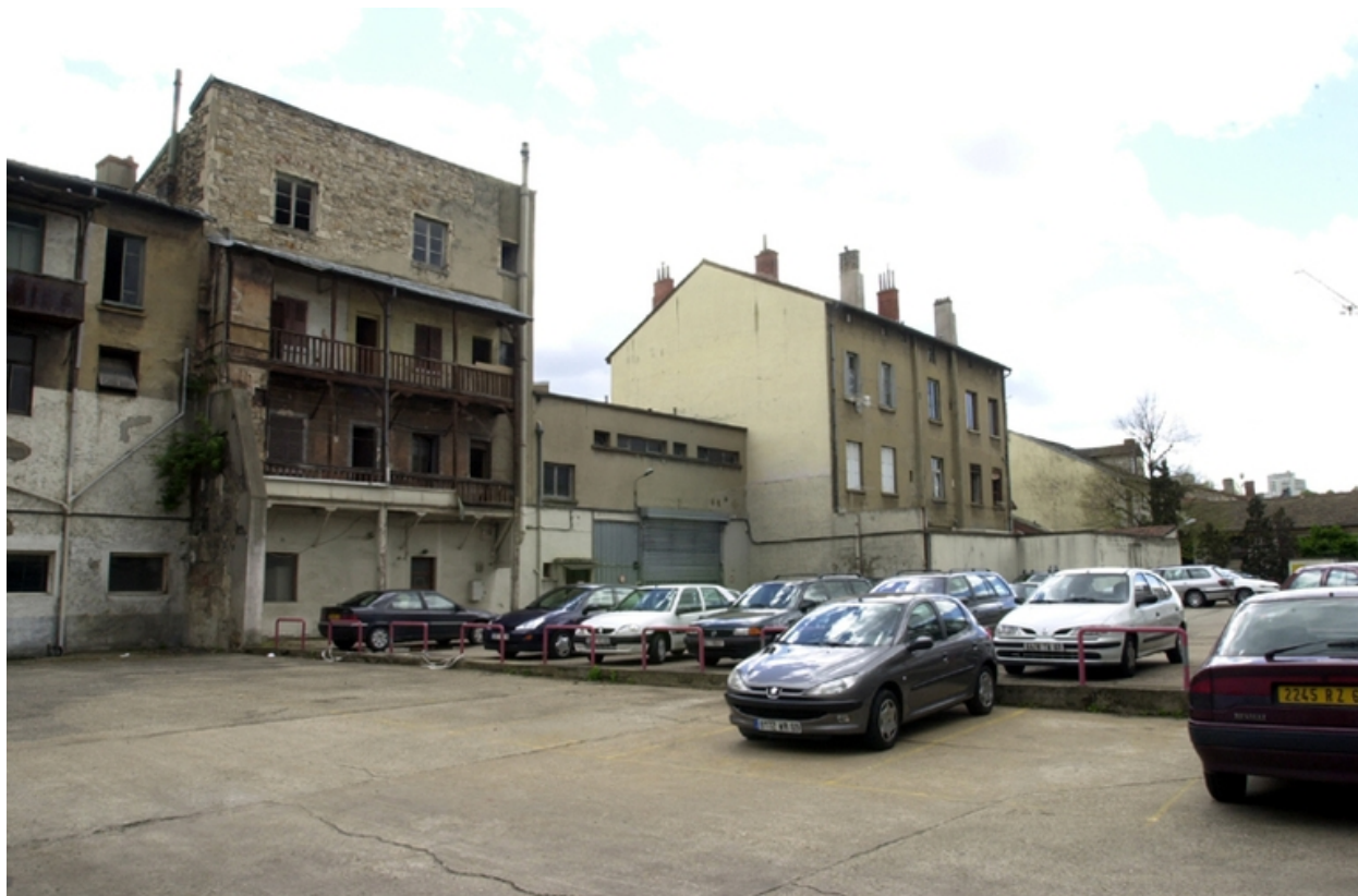
Vue du parking et de l'ancien bâtiment du CE
