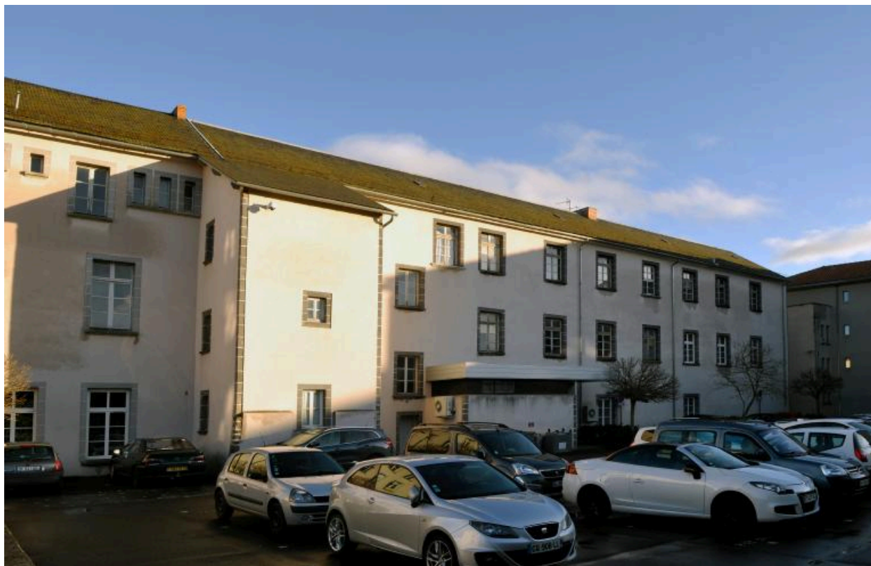
Corps de bâtiment ouest : élévation postérieure
