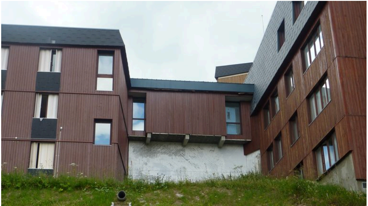
Jonction entre les bâtiments B1 et B2 vue depuis le nord
