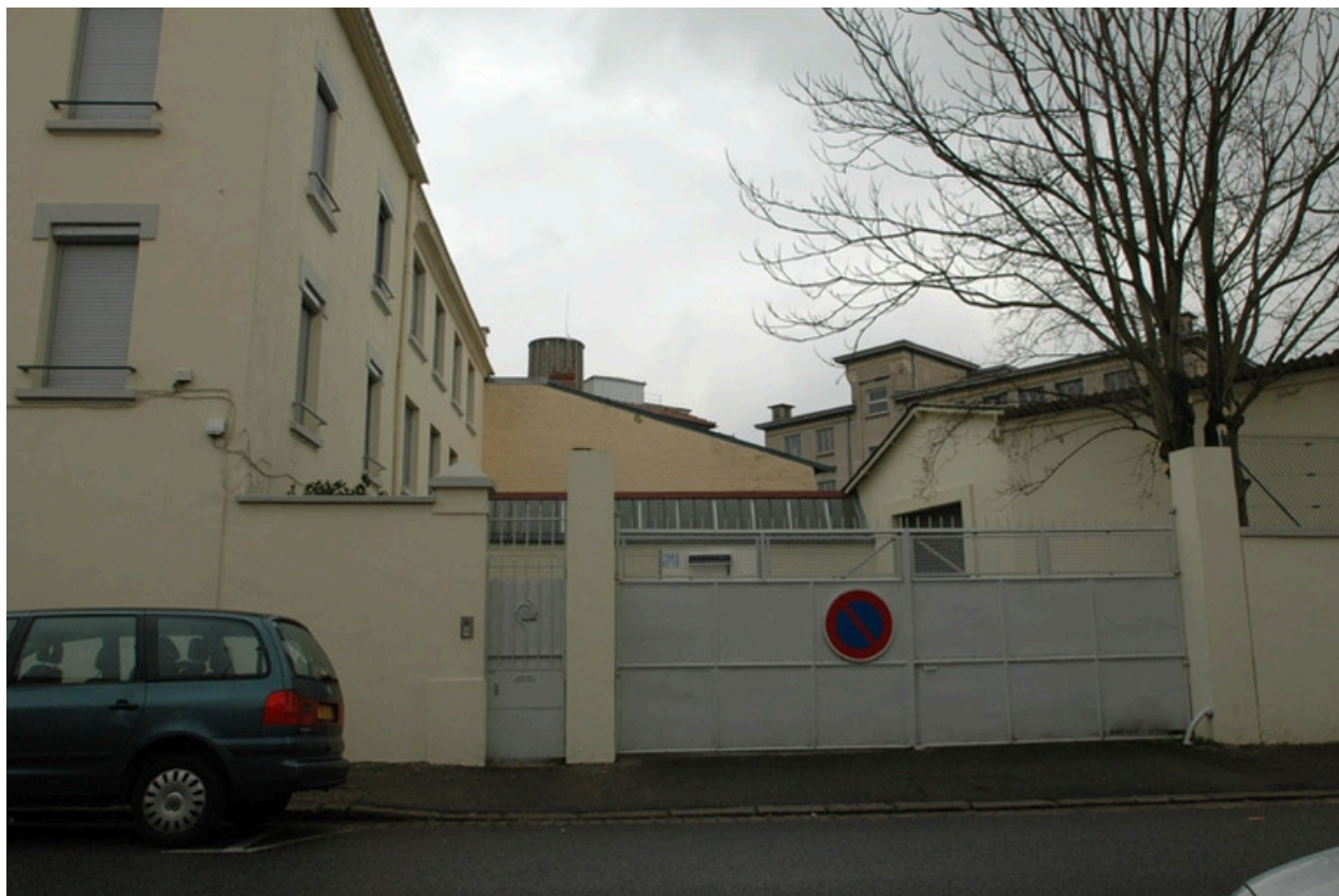
Entrée principale rue Roux Soignat, vue ouest.
