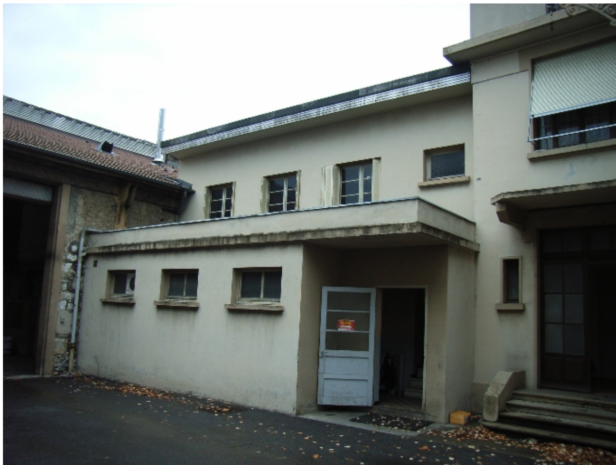
Bâtiment avec vestiaire, première cour
